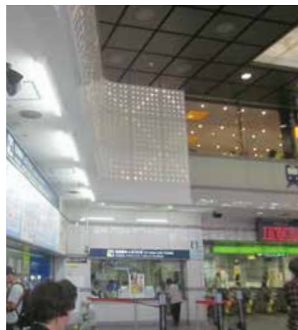
LED照明(金山駅)
