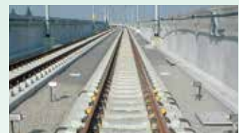
センサー設置状況
