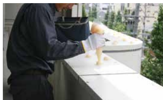
防鳥用忌避剤施工
