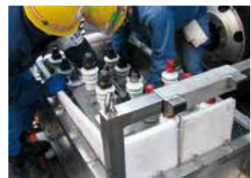
PCB廃棄物の搬出作業
