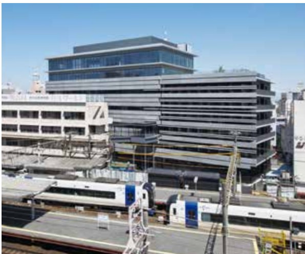
鉄道センタービル
