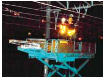
電気保守作業
