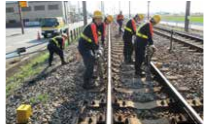
土木保守作業
