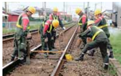
土木保守作業
