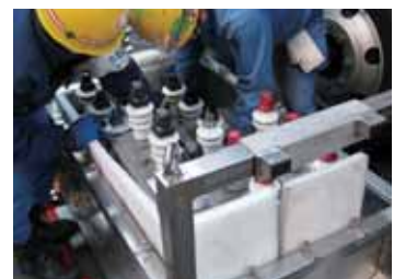
PCB廃棄物の搬出作業
