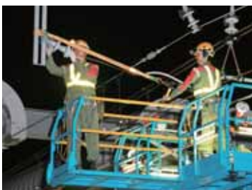
電気保守作業
