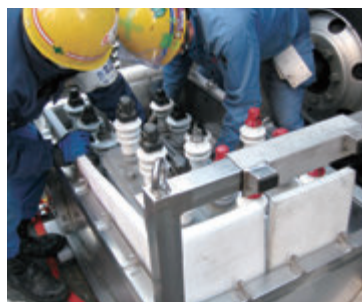
PCB廃棄物の搬出作業
