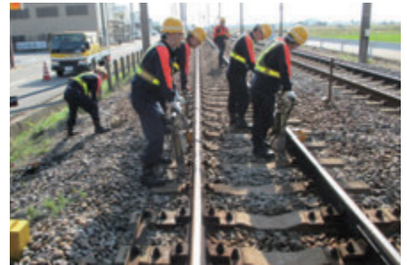
土木保守作業
