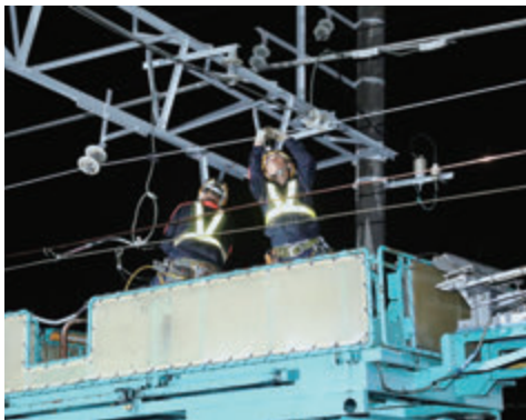
電気保守作業
