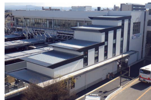
新城駅改良（橋上駅化）
