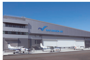
中日本航空本社整備工場
