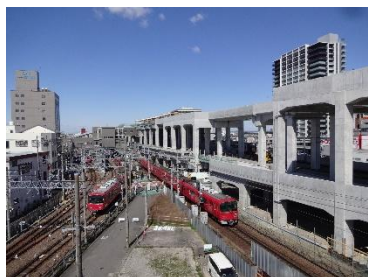
知立駅付近の高架化工事
