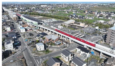
若林駅付近の高架化工事
