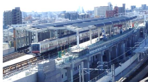
喜多山駅付近の高架化工事
