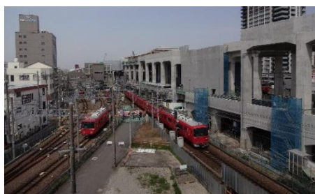
知立駅付近の高架化工事
