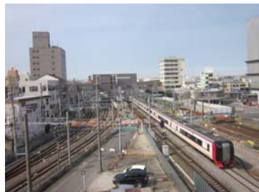
知立駅付近高架化工事
