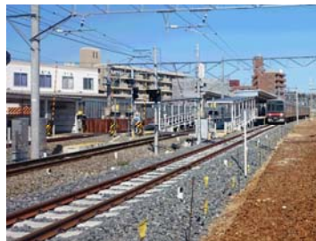
喜多山駅付近高架化工事
