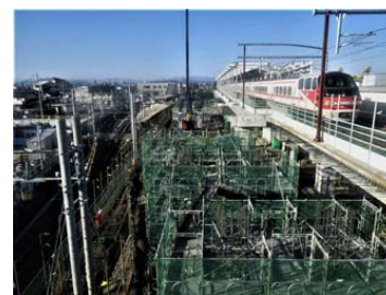
布袋駅付近高架化工事
