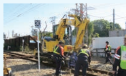
線路の復旧作業
