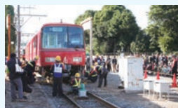
脱線した車両の復旧作業
