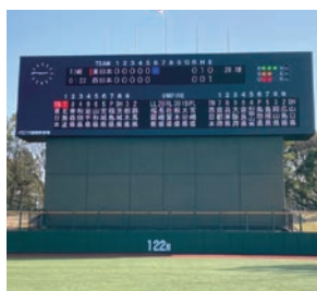
大型映像装置施工事例 (パロマ瑞穂野球場)
