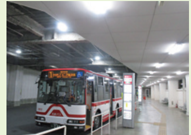
照明をLED化した 国府宮駅立体駐車場
