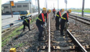
土木保守作業
