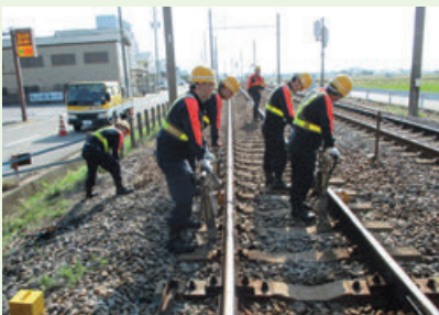
土木保守作業
