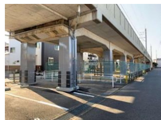
高架橋の耐震補強
